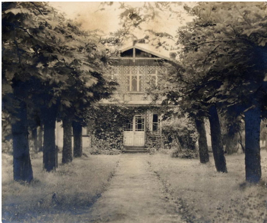
Abb. 2. Riga, Kleine Kandauer Straße 3 (maza Kandavas iela) in Sassenhof (Zasulauks) Alexanderhalt. Links vorn unten sieht man den einen Zuweg zum Vorderhaus (vor 1940).
